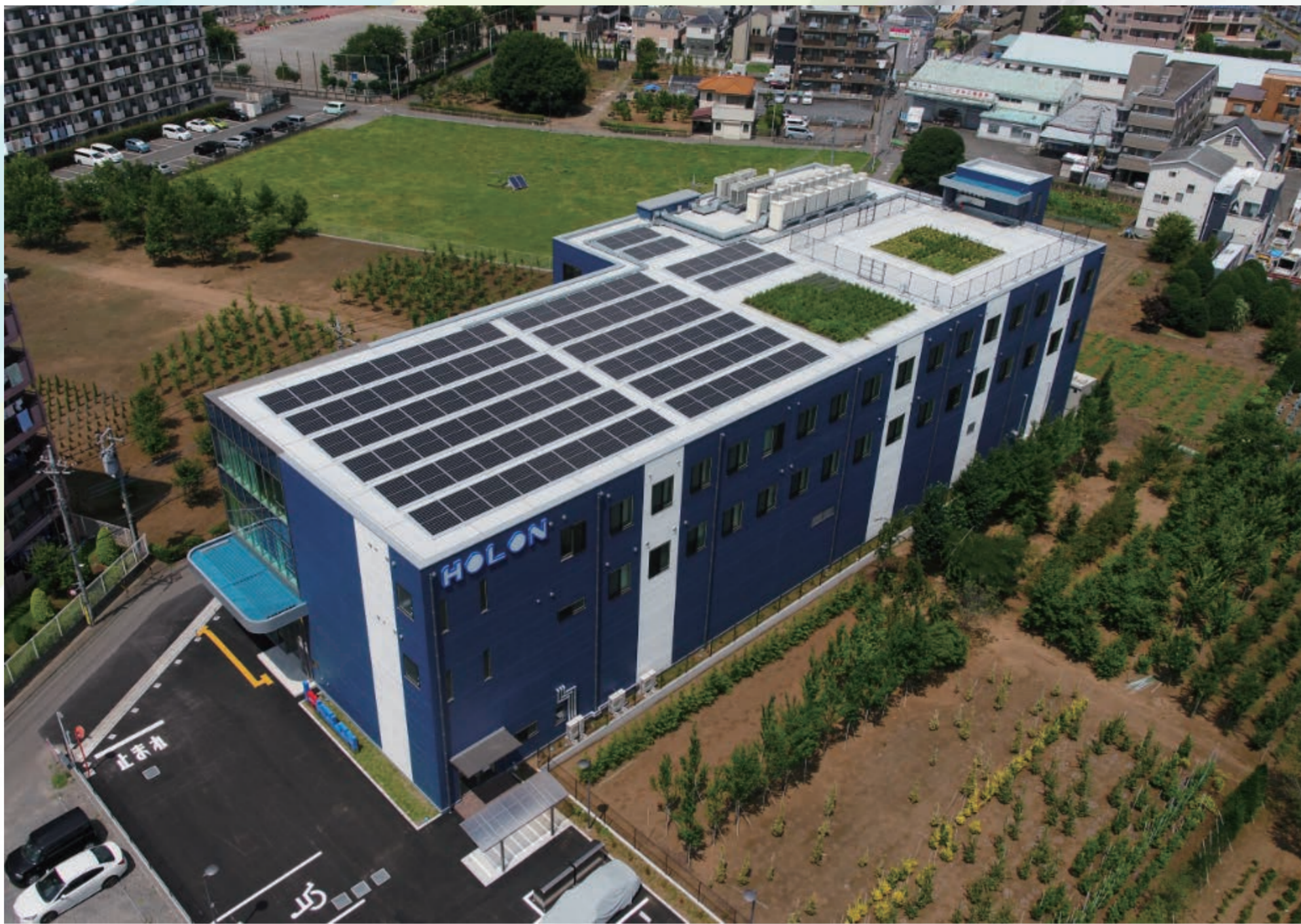
ホロン 太陽光パネル設置風景
